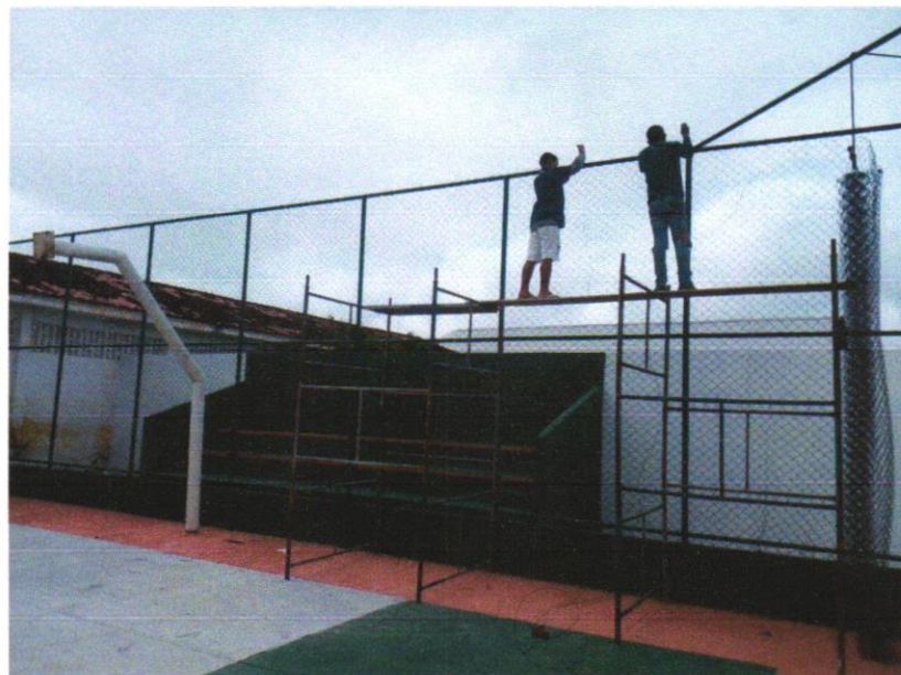
Foto 02 – ALAMBRADO PARA QUADRA POLIESPORTIVA, ESTRUTURADO POR TUBOS DE AÇO GALVANIZADO, (MONTANTES COM DIÂMETRO 2", TRAVESSAS E ESCORAS COM DIÂMETRO 1 ¼ ), COM TELA DE ARAME GALVANIZADO, FIO 10 BWG E MALHA QUADRADA 5X5CM (EXCETO MURETA). AF_03/2021
