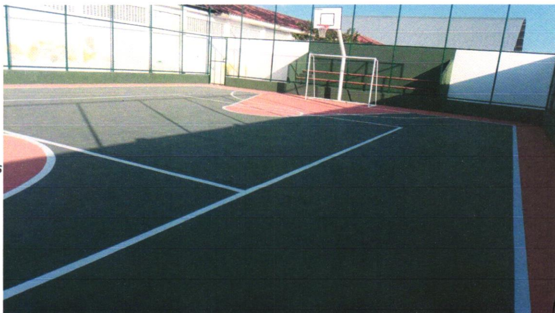
Foto 08 - PINTURA DE DEMARCAÇÃO DE VAGA COM TINTA ACRÍLICA, E = 10 CM, APLICAÇÃO MANUAL. AF_05/2021
